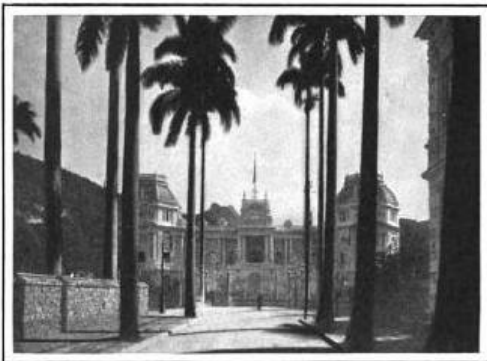
THE PALACE GUANABARA AT RIO DE JANEIRO
